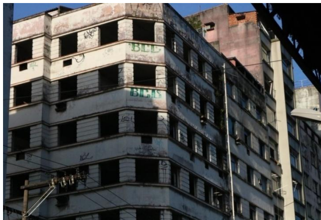
Figura 1 - Edifício localizado no centro da cidade de Vitória - ES, em frente ao Porto de Vitória, 2019. Fonte: Arquivo pessoal.
